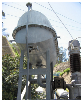
Figura 7. Instalacion del Relé Buchholz en un transformador de potencia.
