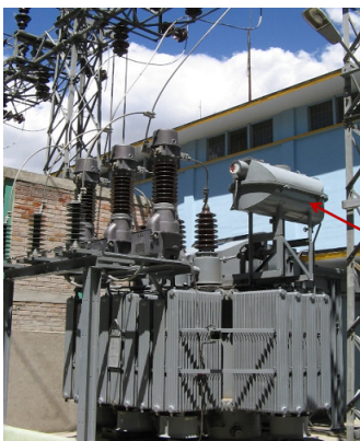
Figura 1. Protección Relé Buchholz Transformador de Potencia.
